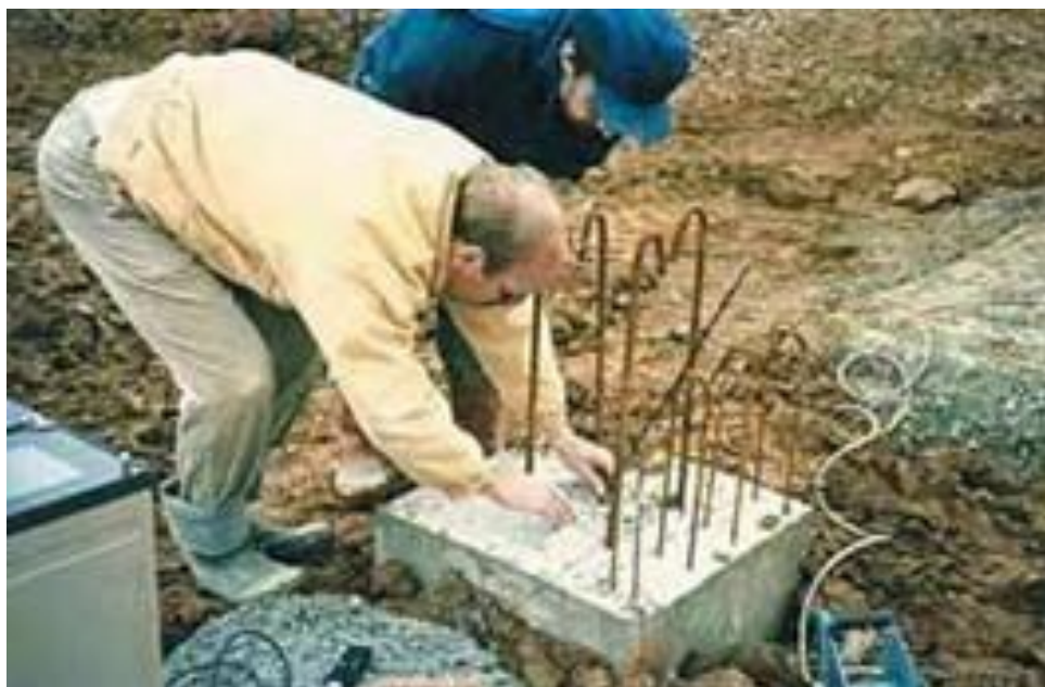
FIGURE 3.19 – Préparation de la tête de pieu pour le test.
