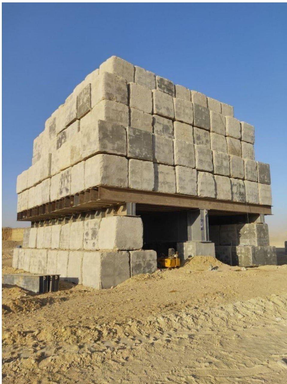
FIGURE 4.1 – Image d'un test de pieux de charge statique standard utilisant des blocs de béton comme charge permanente.
