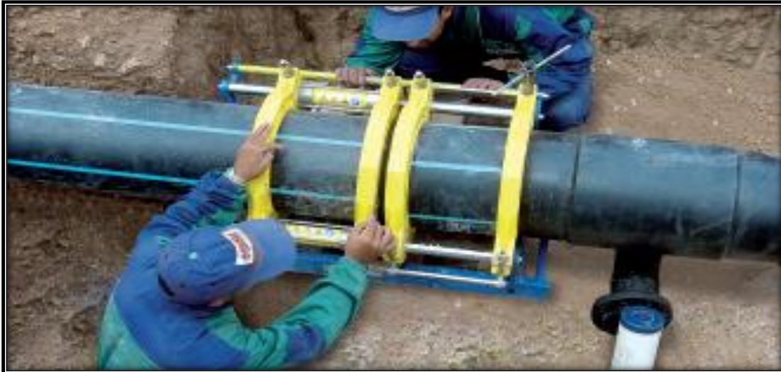
Figure V- 4 : Le soudage bout à bout des tubes en polyéthylène (PEHD)
