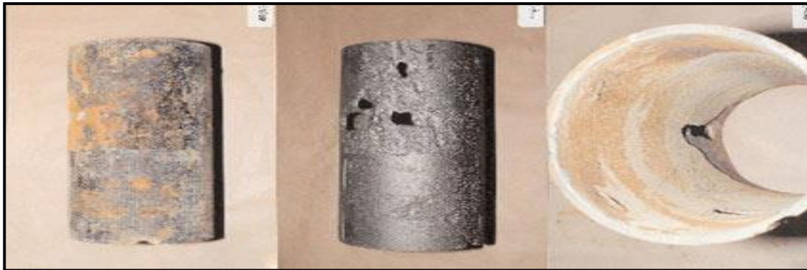
Figure IV- 1 : Corrosion des conduites en fonte ductile
