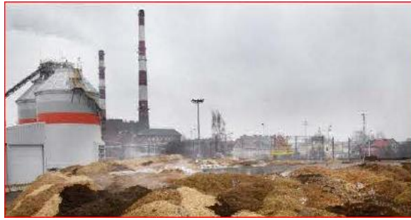
Figure 1-3 Centrale thermique à biomasse
