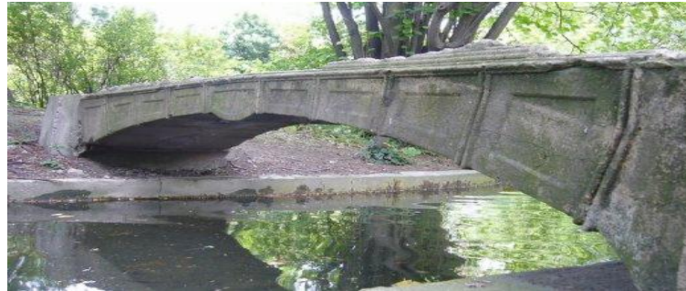
Figure I. 1 : Premier pont en béton de L. Vicat (1853)
