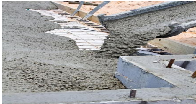
Figure I. 7 : un béton auto plaçant lors de collage.
